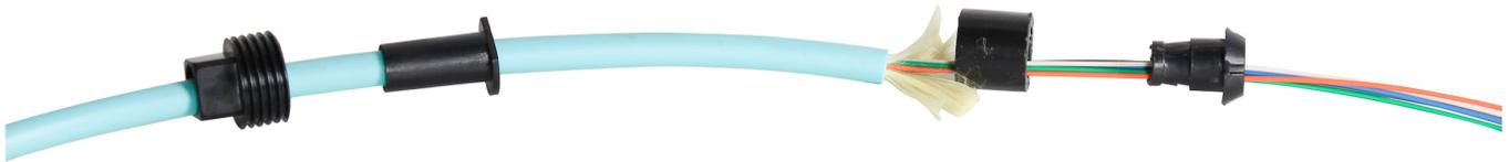
**PASO 2:** Se realiza con el pelador Optronics el desforre de la cubierta exterior del cable, **aproximadamente 1.10 m de longitud.**
